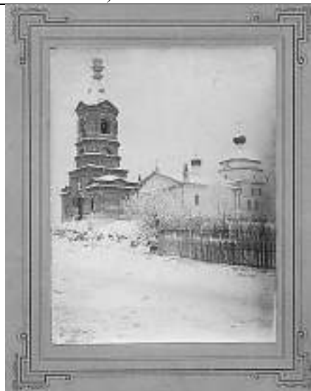
Каменная колокольня при деревянной церкви Николая Чудотворца
