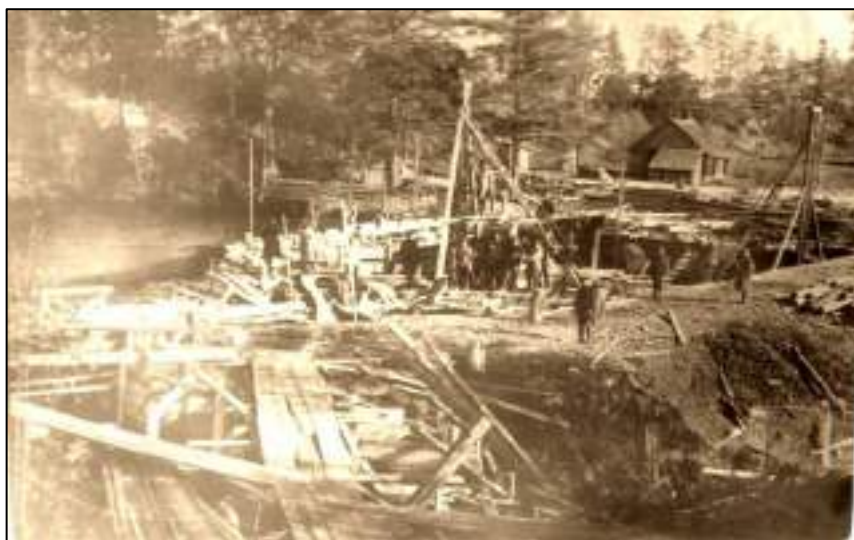
Ремонт плотины на р.Хоринке в м.Марино. Верхний бьеф. (Из архива С.А. Шувалова)
