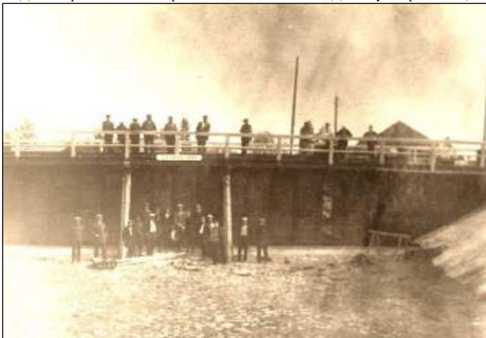
1931г. Верхний бьеф плотины на р.Перетне перед пуском воды. Надпись: «Сооружена в 1931 г»
