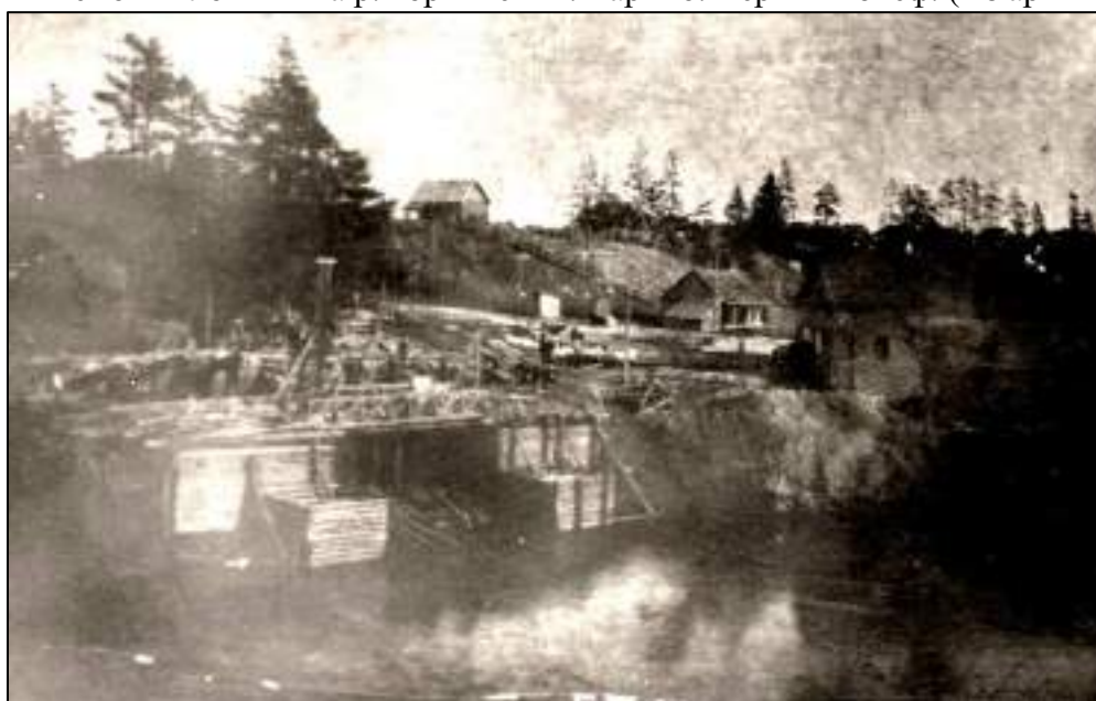
1931г. Нижний бьеф плотины на Марине во время ремонта
